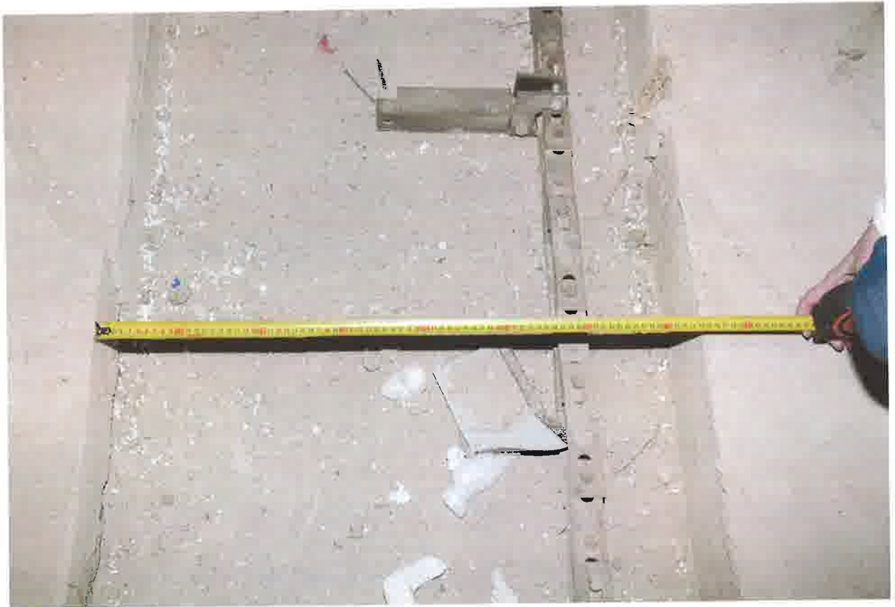
Фото 26. Размеры канала навозоудаления в месте прохода технологического транспорта.
