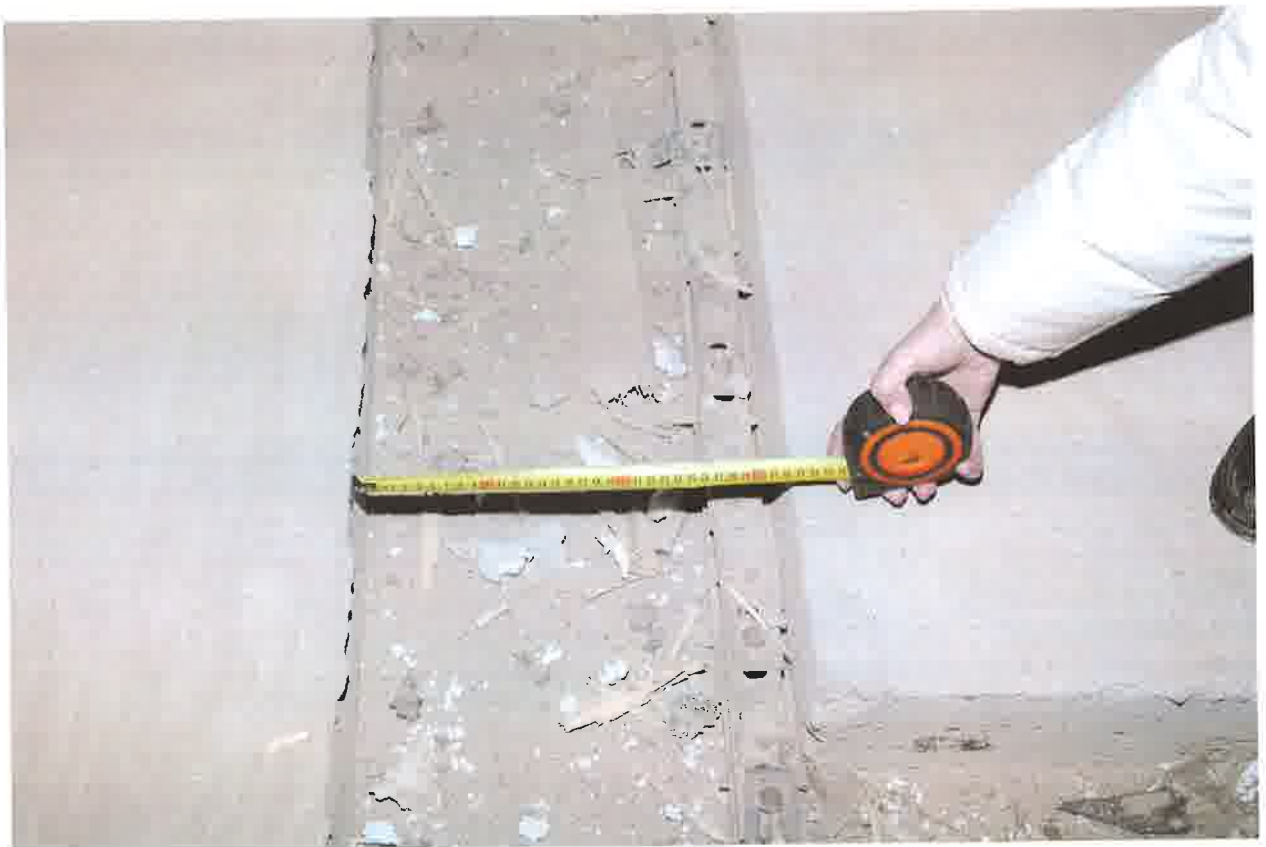
Фото 25. Размеры канала навозоудаления.
